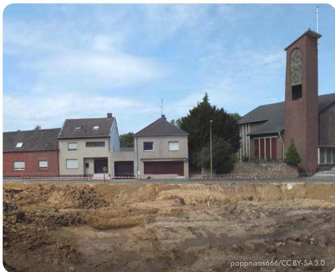
Verschwundener Ort: Inden-Pier vor dem Abriss im Jahr 2021
